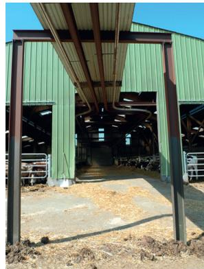
Photo 7.3 : Rail fixé sur portique. Le rail électrifié est protégé des intempéries par une tôle
