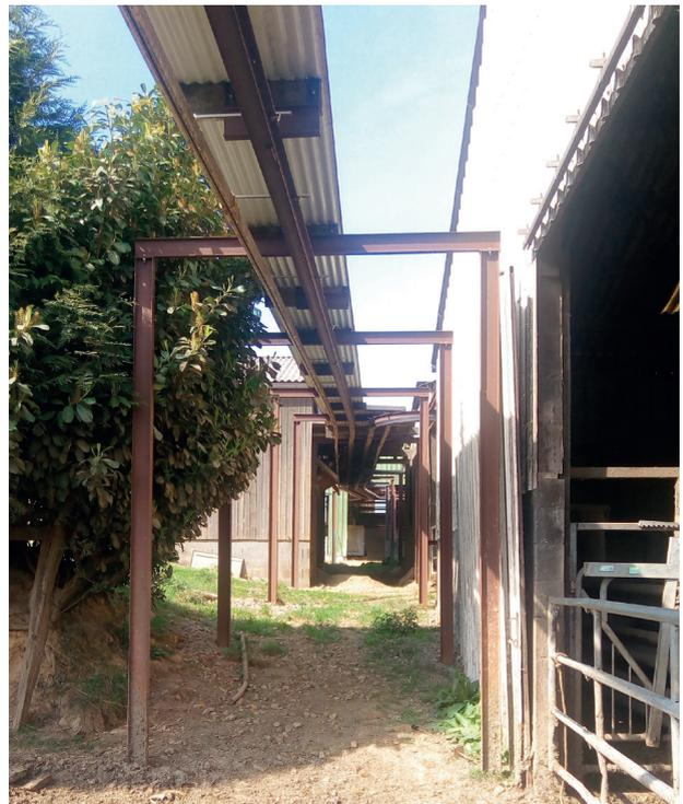
Photo 14.9 : Pente sur rail pour bâtiment décalé
