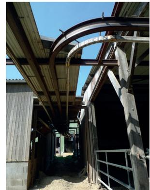
Photo 7.4 : La fixation des rails sur bâtiments existants peut être compliquée et nécessite parfois de nombreuses courbes et aiguillages
