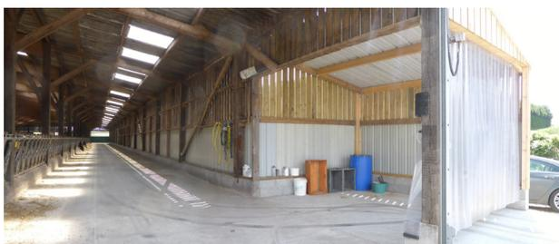
Photo 11.1 : Entrée déportée pour le robot, fermée par un portail fait de lanières plastiques ce qui permet de maintenir fermé le grand portail du couloir d'alimentation les jours de vent et de pluie
