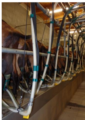
Photos 5 et 6 : Installations de traite, ligne basse à gauche : le lait s'écoule par gravité vers le lactoduc situé sous le quai, et ligne haute à droite : le lait remonte vers le lactoduc situé bien au-dessus du quai
