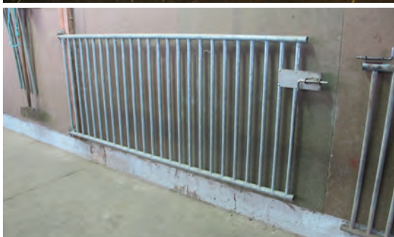
Photo 6 (haut) Photo 7 (bas) : gond et fixation entre barrières « standard » en bois ou en métal.
