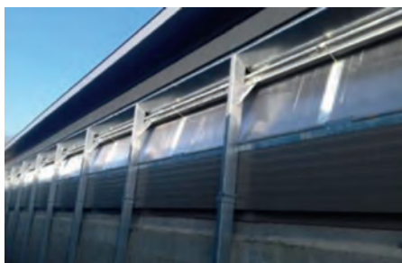
Photo 15 : les ouvertures à soufflet s'inclinent vers l'intérieur de la chèvrerie.
