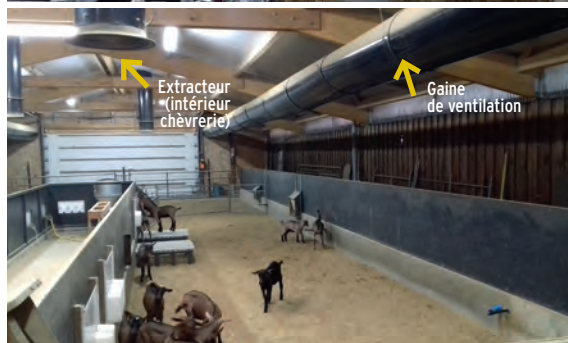
Photos 20 et 21 : Dans une installation de ventilation dynamique par extraction, les trappes ou les volets d'entrées d'air sont de petite dimension et de type libre.
