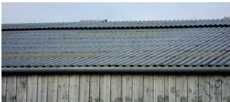
Photo 11 : les écailles en toiture, une solution simple, peu exigeante et très efficace.
