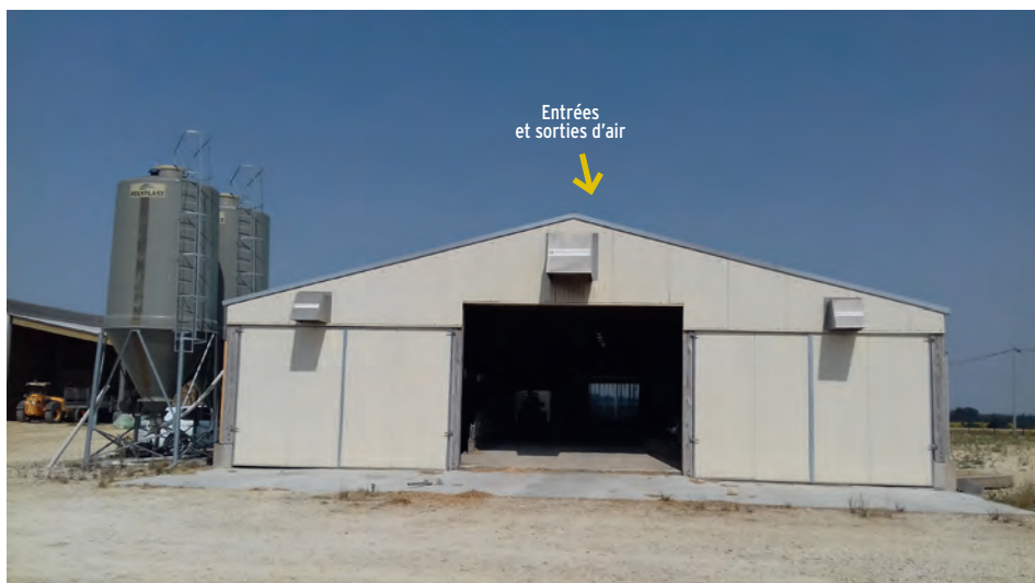
Photos 23 et 24 : Ventilation dynamique par surpression dans une nurserie bipente. Les entrées et les sorties d'air sont assurées en pignon.
