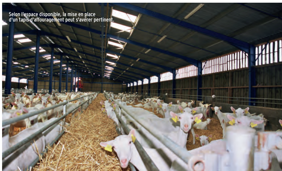
Réfléchir à la largeur des couloirs d'affouragement en tenant de l'évolution du système d'alimentation.
