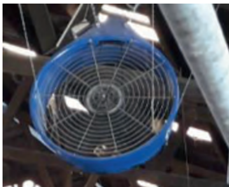
Photo 17 : VES36, ventilateur à flux horizontal avec déflecteur prenant peu de place dans la chèvrerie.
