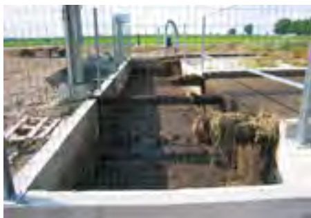
Photo 44 : Pré-fosse rectangulaire en béton (crédit photo : Idele)
