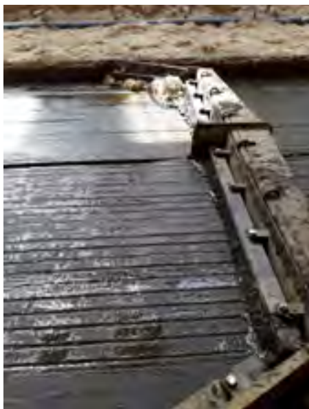
Photo 9 : Racleur droit pour le raclage de lisier (crédit photo : Idele).
