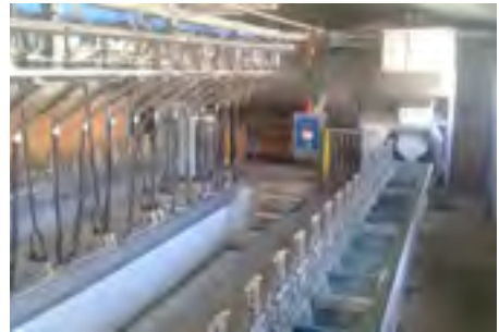
Photo 29 : Salle de traite parallèle en simple équipement avec distribution automatique du concentré en élevage ovin (crédit photo: Idele)
