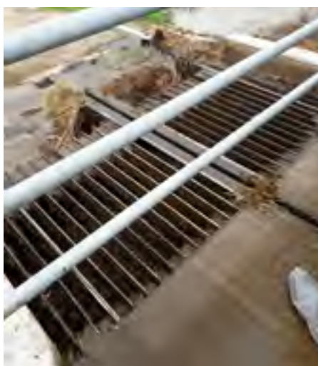
Photo 10 : Grille d'égouttage du fumier pour faciliter son stockage (crédit photo : Idele).
