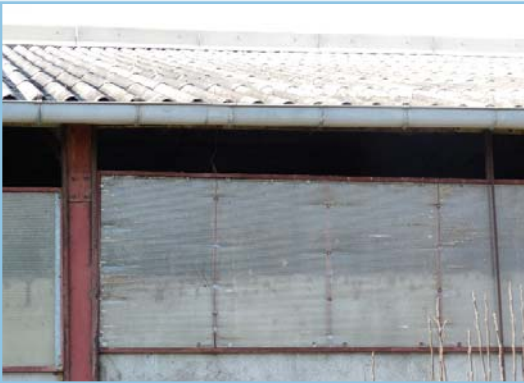
Situation initiale de guillotine standard : deux exemples avec un bardage translucide différent (vue extérieure)
