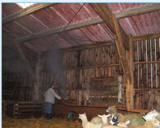
Sur la photo, le test est réalisé vers les entrées d'air.
