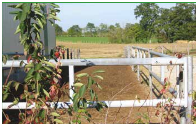
Photo 15 : Sortie du bâtiment vers le pâturage avec sol bétonné et de largeur suffisante pour un accès et un entretien avec tracteur.
