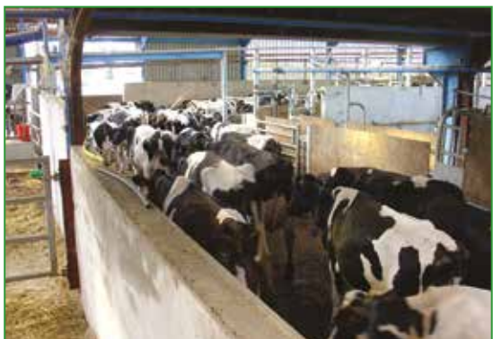
Photo 75 : Accès d'accès à l'aire d'attente de 4,5 m couplé à un couloir de retour de 0,9 m avec parois pleines vers les 2 lots de vaches en production et les différents locaux annexes.
