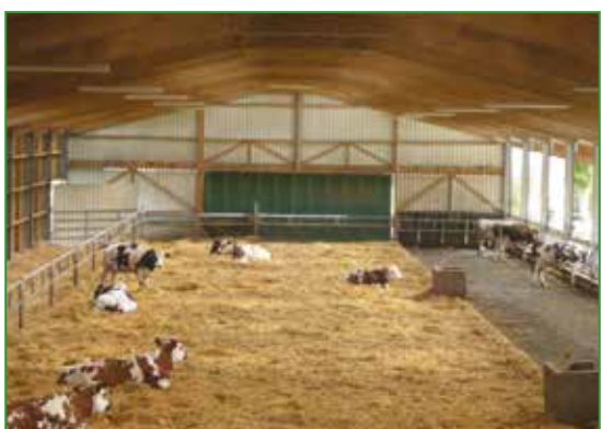
Photo 32 : Un couloir à l'arrière permet non seulement de mieux surveiller les animaux et de les déplacer vers l'isolement mais aussi de pailler à proximité de l'aire de couchage sans entrer sur l'aire de vie et sans salir les abreuvoirs dirigés vers l'alimentation.
