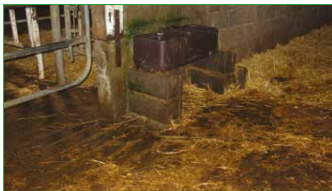
Photo 25 : Avec une aire paillée intégrale, les bacs d'abreuvement sont placés sur une aire bétonnée en bout de quai. L'évacuation de l'eau se fait par une canalisation implantée dans le béton sous l'abreuvoir.
