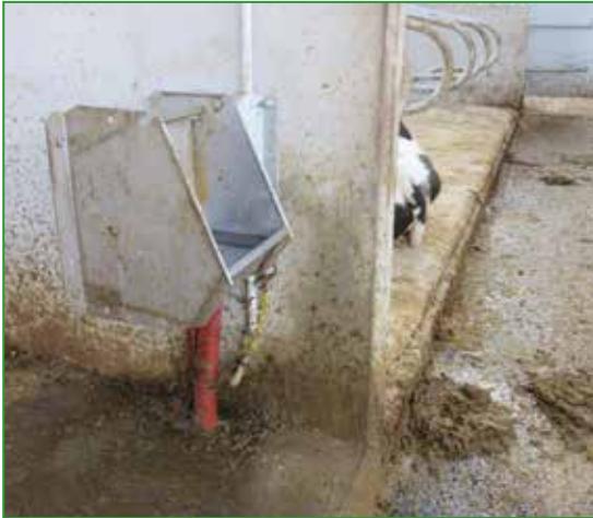
Photo 43 : Abreuvoir individuel placé dans un passage et orienté vers le couloir raclé. Dans ce cas, l'abreuvoir doit être placé en retrait du seuil d'une dizaine de centimètres et à bonne hauteur pour que l'animal garde les antérieurs dans le couloir.
