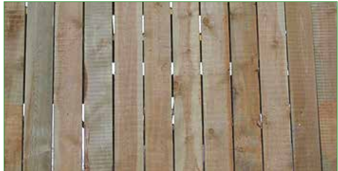
Photo 85 : Un bardage en bois ajouré avec fentes irrégulières et peu larges.
