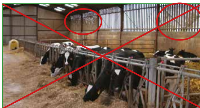
Photo 8 : Bâtiments poussiéreux : attention aux problèmes respiratoires et à l'efficacité de la ventilation : un entretien régulier s'impose.
