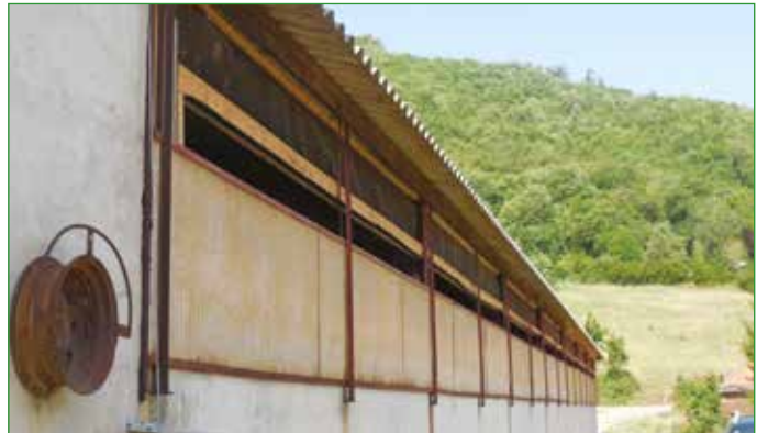
Photo 87 : Ouverture « guillotine » avec protection brise-vent lors d'une ouverture partielle.
