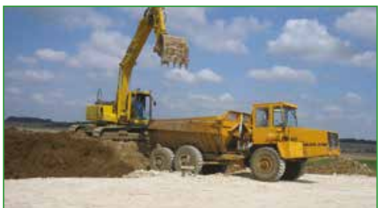
Photo 24 : La qualité du sous-sol d'une aire paillée débute au terrassement.
