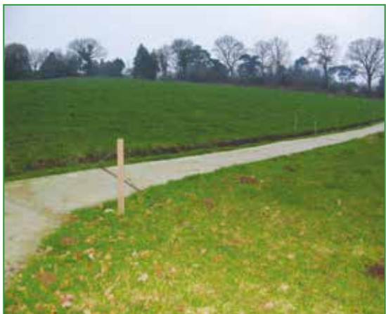
Photo 16 : Chemin principal en béton conforme aux recommandations.
