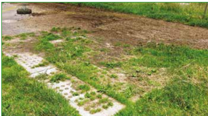
Photos 17 et 18 : Chemins et entrées de parcelle (5X5m) stabilisés avec des caillebotis de récupération avec pousse d'herbe et terre dans les ouvertures ce qui améliore leur confort et leur souplesse : saisissez l'opportunité si elle se présente...
