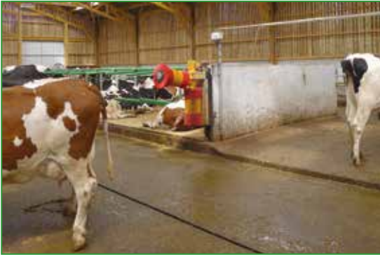
Photo 39 : Passage avec double pente vers les couloirs et marche réduite, en conduite lisier et racleage fréquent.
