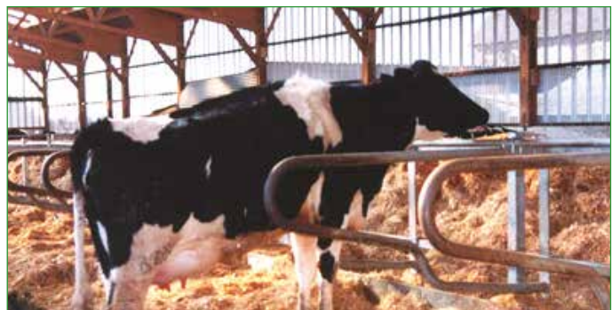
Photo 86 : Beaucoup de luminosité dans le bâtiment avec des tôles perforées mais une mauvaise protection contre les intempéries.
