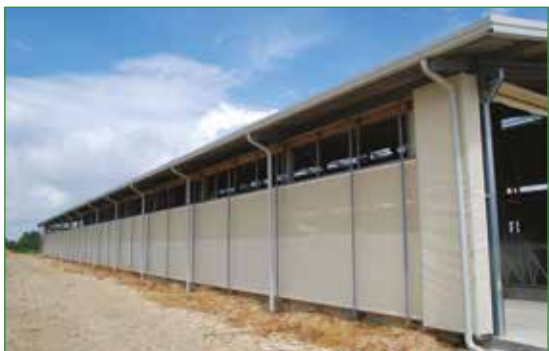
Photo 88 : Bardage mixte brise-vent/bâche enroulable sur presque toute la surface du long-pan.
