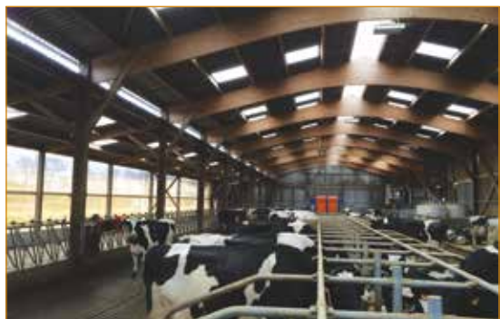
Photo 93 : Vue intérieure illustrant la lumière entrant sur les aires de vie par des plaques (bardage et toiture) et brise-vent.
