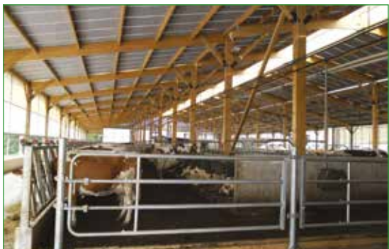
Photo 91 : Décalage de toiture - Crédit photo : Sté Interamas-Celloplast
