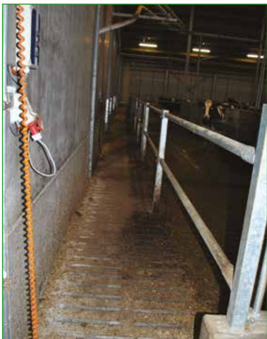
Photo 71 : Couloir de circulation des hommes entre le couloir de distribution de l'alimentation et les locaux annexes, permettant aussi de surveiller l'aire de vie des animaux, sans y entrer.
