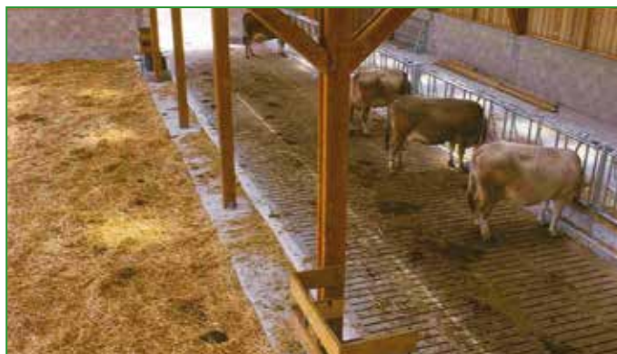
Photo 26 : Installation d'une double marche entre l'aire paillée et l'aire d'exercice caillebotisée et d'abreuvoirs accessibles de l'aire d'exercice.
