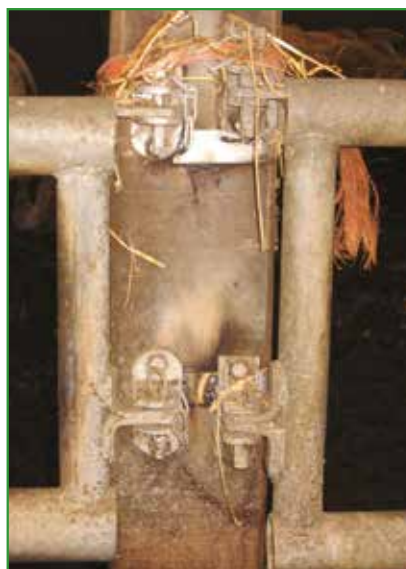
Figure 11 : Les liaisons équipotentielles dans un bâtiment (source : GIE Élevages de Bretagne, Groupama Loire Bretagne, 2005)
