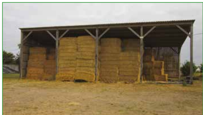
Photo 30 : Paille stockée sous abris : protéger les parois orientées vers les pluies dominantes.
