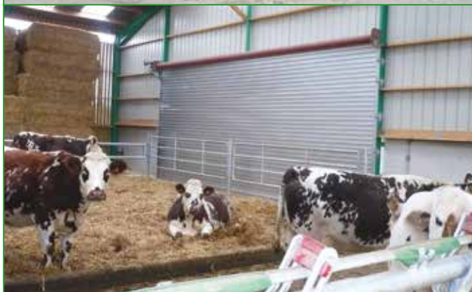
Photos 35 et 36 : Un portail spécifique en lien avec une fumière en contrebas permet de curer efficacement et rapidement l'aire paillée. Le stockage du fumier est géré dans un 2 ème temps, portail fermé.
