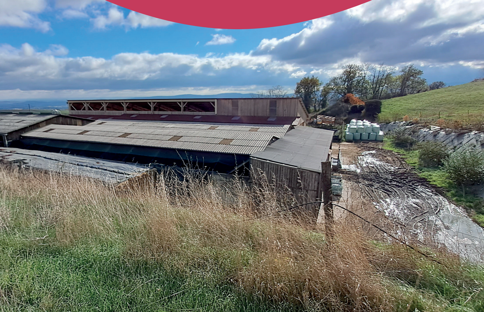
Photo 22 - Vue générale du bâtiment du GAEC du Perret
