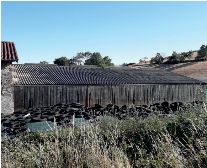
Photo 19 - Bardage fixe avant installation des volets
