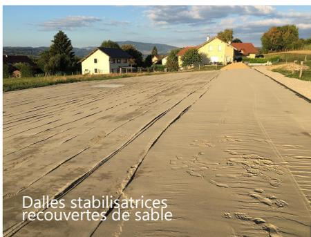
Dalles stabilisatrices recouvertes de sable
