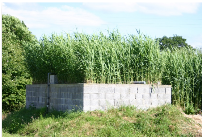
Photo 33 : Le traitement des effluents par les roseaux
