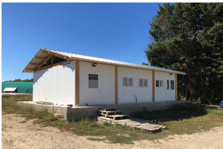
Photo 29 : Fromagerie en panneaux sandwich avant bardage bois
