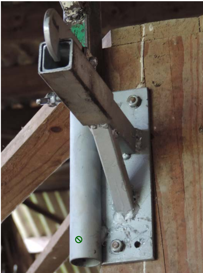
⊗ Tube de serrurier rond 35 X 2 mm
