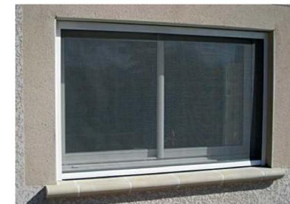
*fenêtre à châssis ouvrant, équipée d'une moustiquaire*
