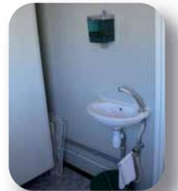
Lavabo à commande non manuelle réalisé à partir d'un lavabo en céramique et d'un système de commande fémorale
