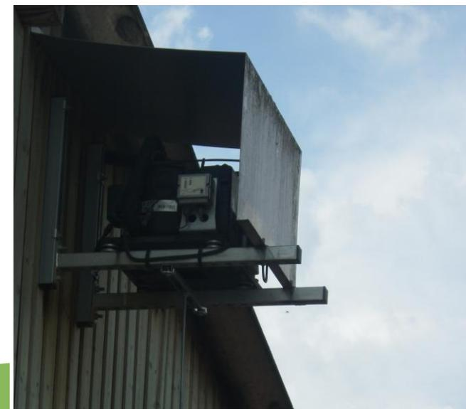
LE COMPRESSEUR EST PLACÉ EN EXTÉRIEUR, À L'ABRI ET AÉRÉ.
