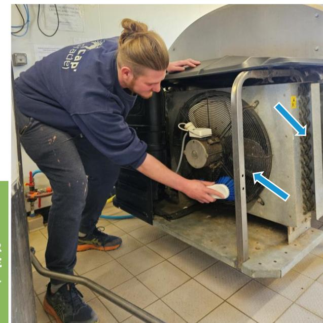
LE NETTOYAGE COMPLET ET RÉGULIER DU CONDENSEUR PERMET UNE MOINDRE CONSOMMATION ÉLECTRIQUE DU TANK.
