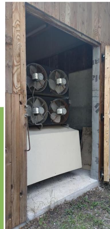
LE COMPRESSEUR DU TANK EST DIRIGÉ VERS L'EXTÉRIEUR ET UNE PORTE PERMET DE L'AÉRER ET DE REFRIGÉRER LA LAITERIE.
