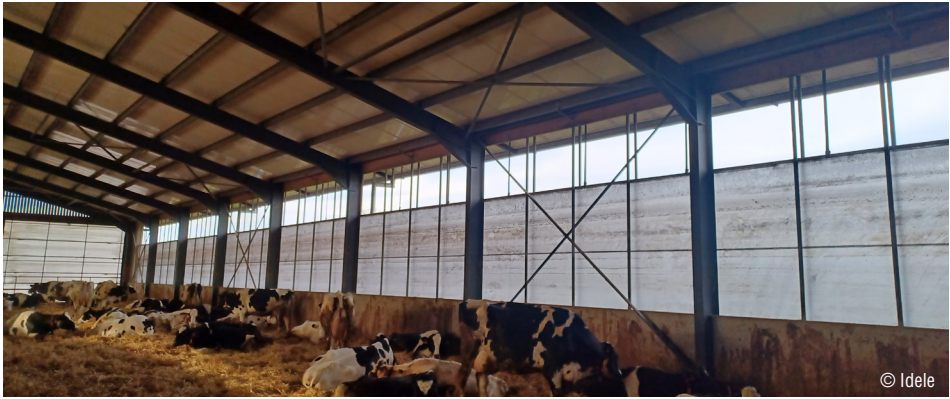
Photo 14 : Le montage d'un rideau en textile plein implique de laisser en permanence une ouverture libre minimale de 30 cm en partie haute.
