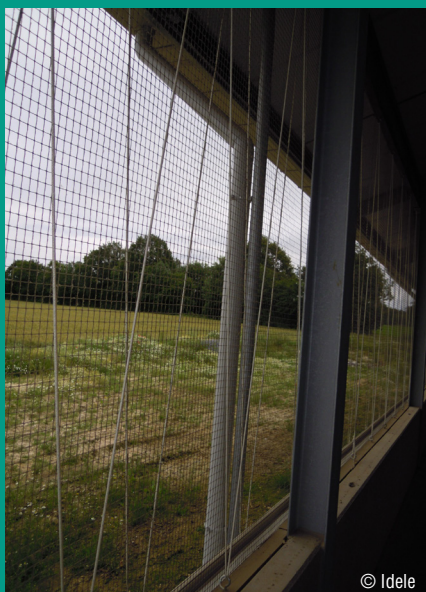
Photo 17 : Pose en complément du rideau d'une grille anti-oiseaux.
