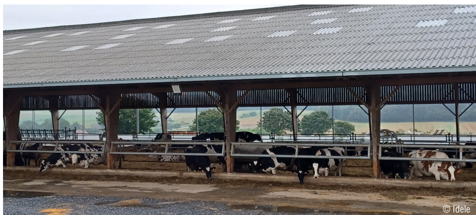
Photo 2 : Une ventilation transversale est à rechercher toute l'année pour permettre à l'air ambiant de se renouveler.
