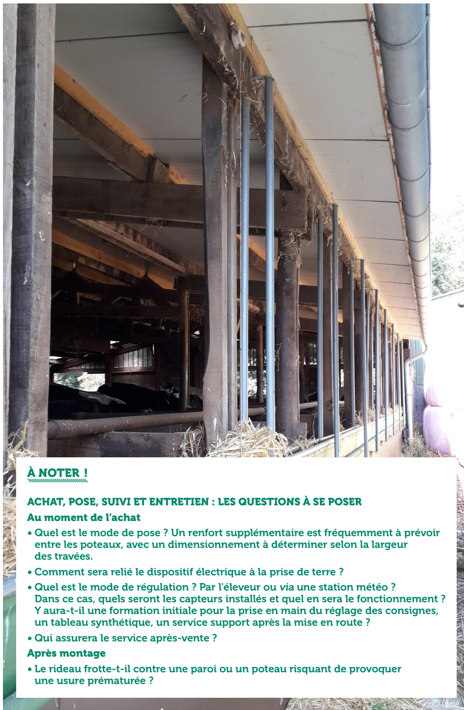
Photo 18 : Un bâtiment rénové avec le remplacement de la couverture par une toiture isolée prolongée en partie basse et un rideau qui a remplacé un bardage fixe, un confort thermique amélioré pour les vaches laitières !
