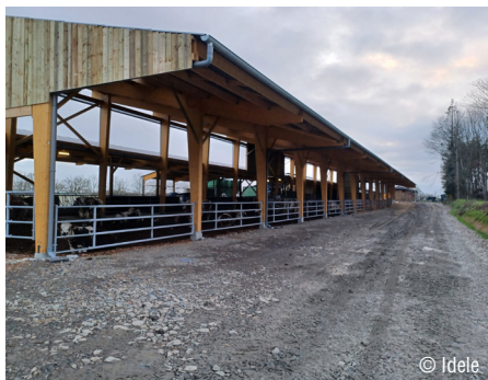
Photo 34 : Une façade de bâtiment 100 % ouverte orientée au nord-ouest.
