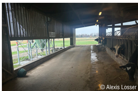
Photo 32 : Le bardage fixe posé sur un cadre est démonté en partie basse en sortie d'hiver.
