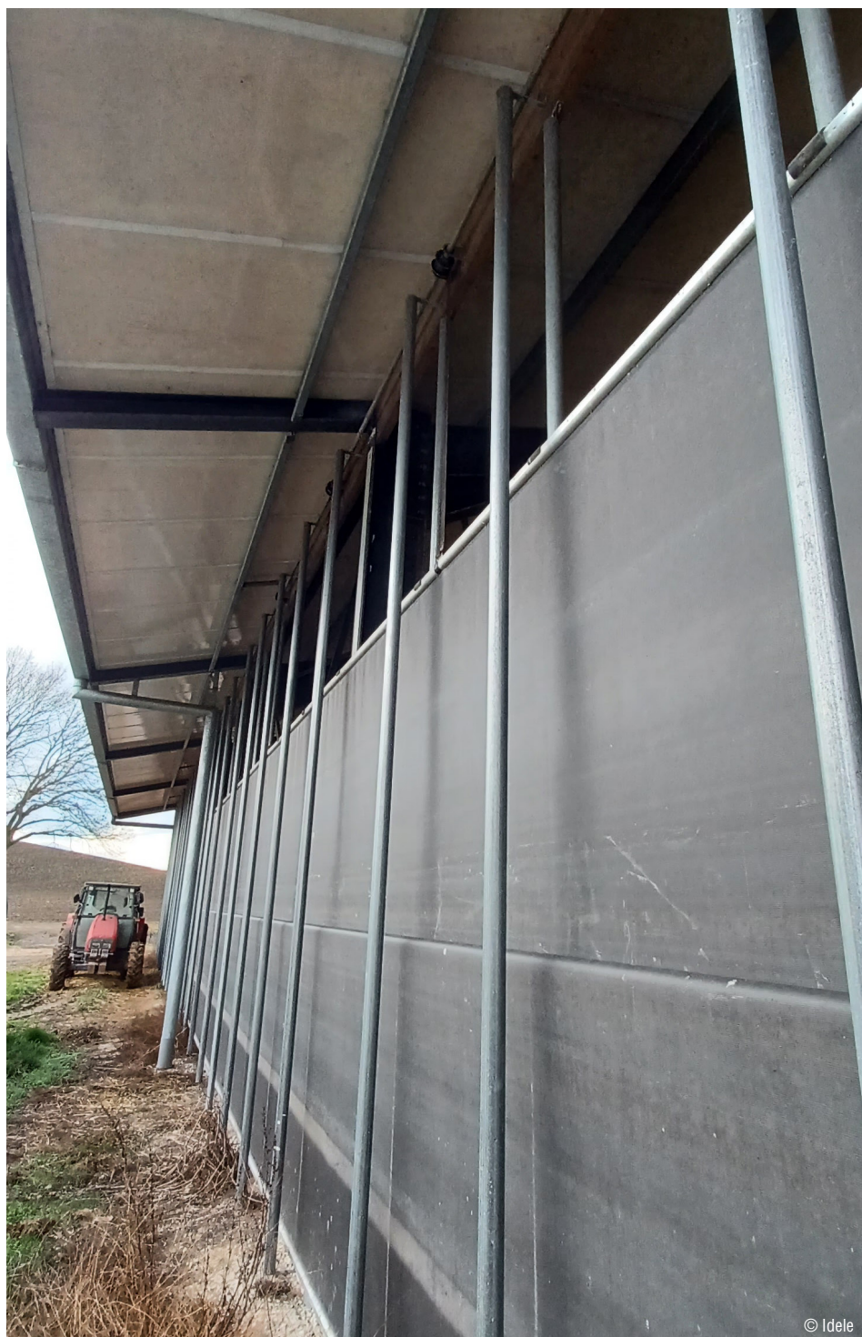
Photo 24 : Un débord au sud protégeant les animaux du soleil et le rideau des intempéries.
