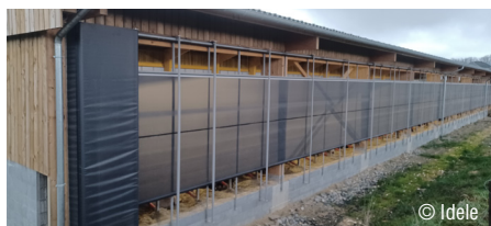
Photo 8 : Un rideau à double ouverture, en partie haute et en partie basse.
