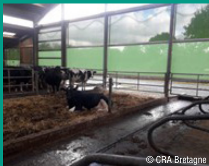
Photo 11 : De la clarté et une ventilation améliorée avec des rideaux en pignon.
