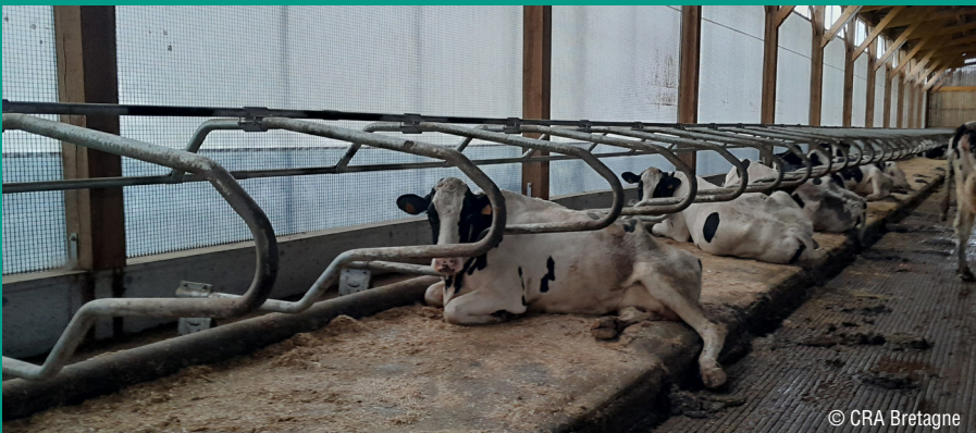
Photo 10 : La maçonnerie est réduite au minimum afin de permettre une ouverture le plus bas possible.
