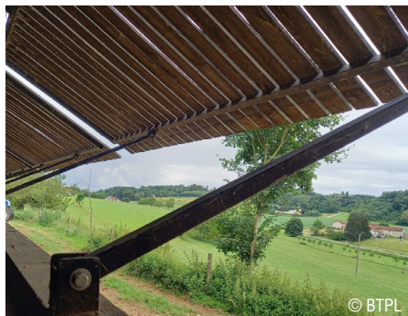
Photo 33 : Des volets pour assurer une ventilation la plus basse possible. L'ouverture vers l'extérieur est préférable pour les orientations au sud ou à l'ouest afin de se protéger du soleil.
