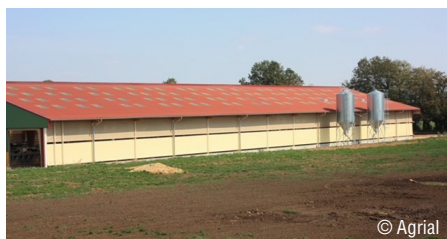
Photo 9 : Le rideau est constitué de deux parties, chacun ouvrant de bas en haut.
