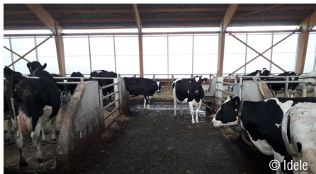
Photo 13 : La luminosité est améliorée en remplaçant des bardages fixes par des rideaux de couleur claire.
