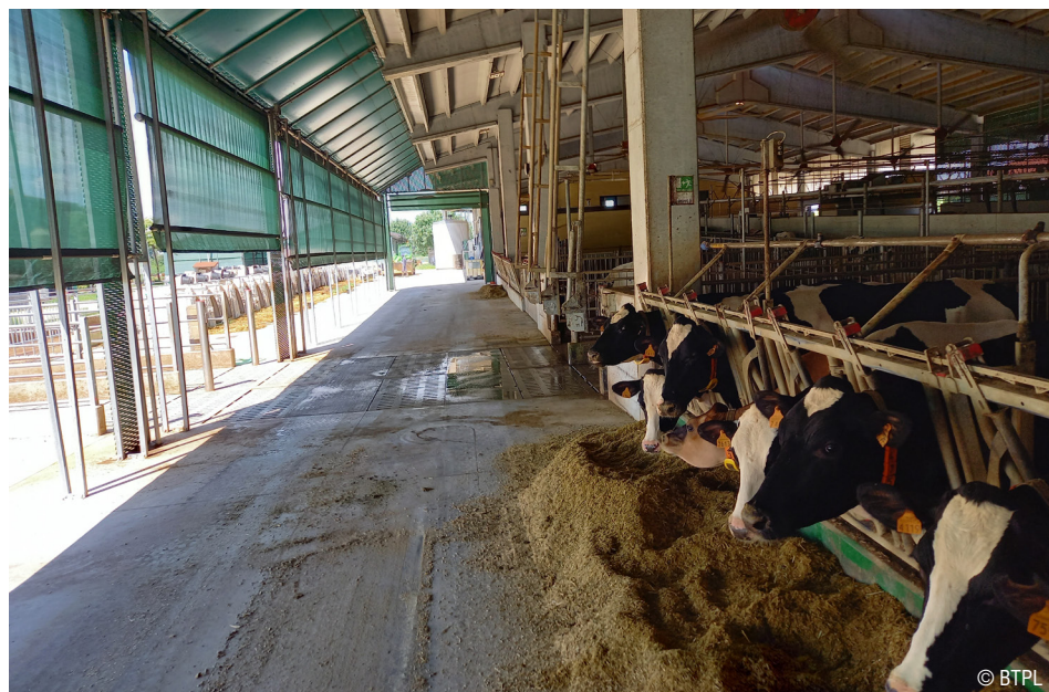
Photo 23 : Les textiles souples peuvent aussi être utilisés pour allonger les avancées de toiture, comme dans cette stabulation italienne.
