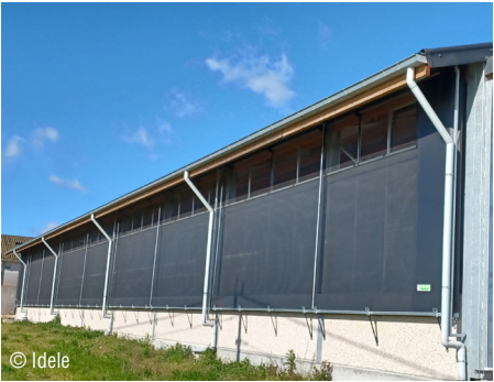
Photo 15 : Que ce soit avec un rideau brise-vent ou en textile plein, laisser un minimum de 30 cm d'ouverture libre protégée par un débord minimal de 50 cm permet de garantir à tous les coups une ventilation minimale en hiver quand les rideaux sont fermés et ainsi d'évacuer plus facilement l'humidité et les gaz produits par les animaux.
