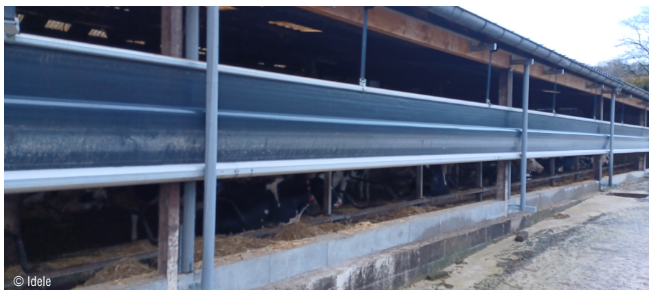
Photo 26 : Avec la double ouverture, il est possible de créer manuellement un bandeau pour éviter que le rayonnement solaire n'affecte le confort thermique des vaches.
