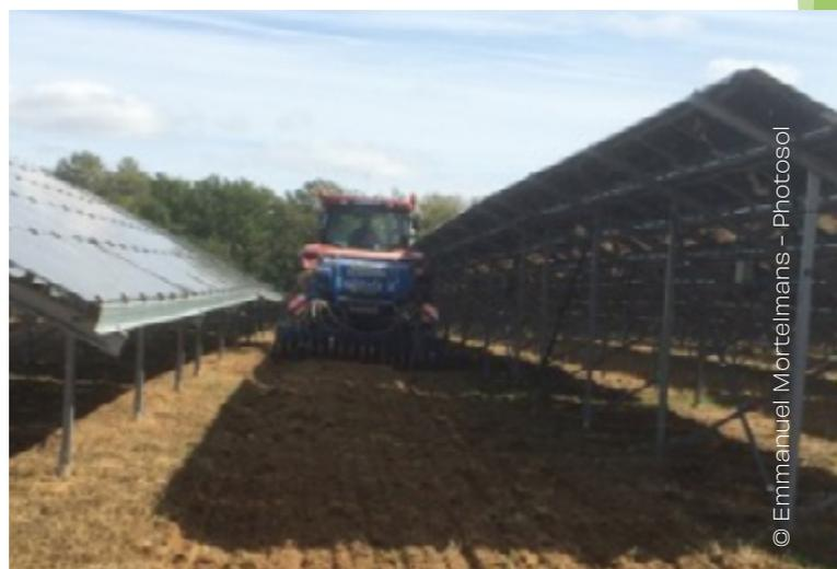
**Un espacement suffisant entre les rangées de panneaux doit permettre aux engins agricoles de circuler**
