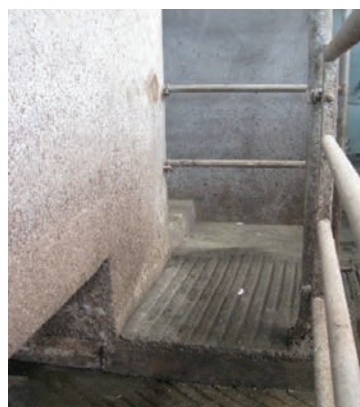
Photo 18 : Couloir de retour de traite à risque : angle trop serré associé à la présence d'une marche (crédit photo : A. Charrette - Seenovia)
