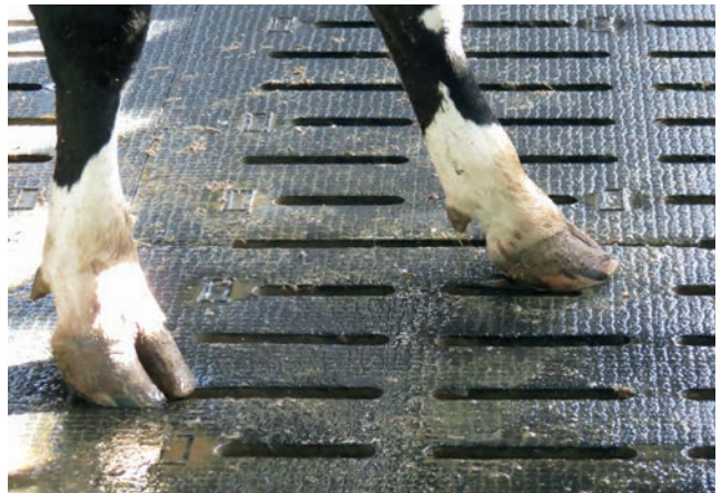
Photo 20 : Caillebotis avec tapis ajourés au niveau du couloir d'alimentation (crédit photo : JL Ménard - Idele)
