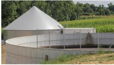
Stockage de lisier de canard et unité de méthanisation: les repères économiques des pratiques environnementales reposent sur les retours d'expérience épars et ne reflètent pas toujours la diversité des itinéraires techniques. © C. Rivet
