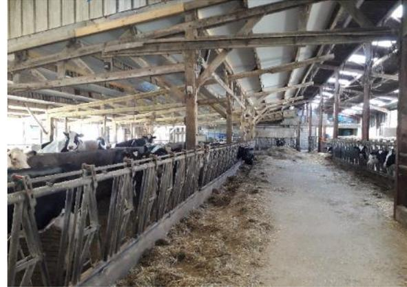
Gain possible de 0 à 2°C de température au globe noir en isolant la toiture suivant les situations
