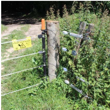
Photo 5 : Clôture de type High Tensile®
