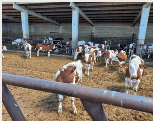
Lot de Montbéliards sevrés à l'engraissement. Bâtiment ouvert sur un grand côté, sur zone d'exercice et zone d'alimentation non couverte. Au sol, mélange de déjections et de paille transformée en terre battue sèche.
