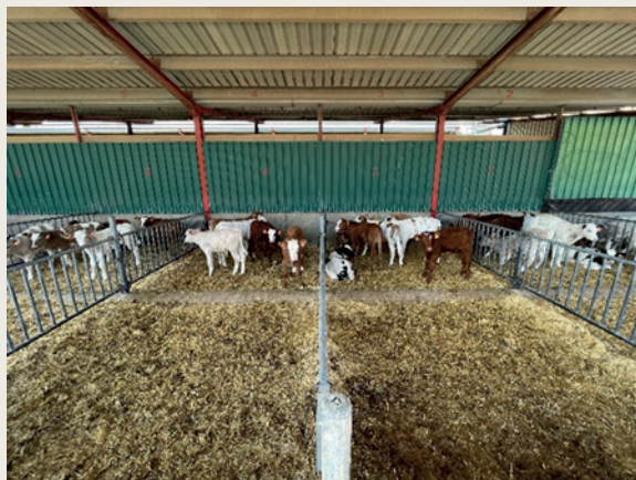
Bâtiment bas en tôle, charpente acier (phase lactée). 5 veaux/case.
