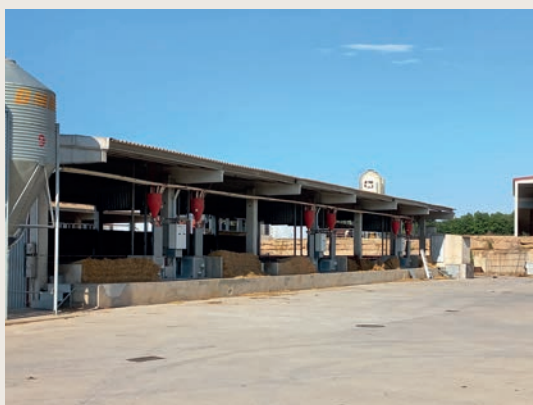
Bâtiment d'engraissement récent de 80 bovins, avec silos, distribution automatique des granulés à heure fixe et paille. Investissement : 700-1 000 €/place pour 1 000 bovins sur ce site.
