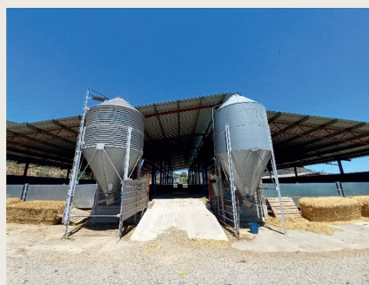
Site d'engraissement récent en acier et tôle, ouvert sur 4 côtés, logeant des veaux allaitants et croisés viande-viande, phase post-lactée.
