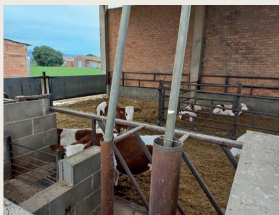
Bâtiment pour veaux en sevrage (post-phase lactée) ouvert sur 3,5 côtés, avec toiture haute pour la bonne ventilation. Les bâtiments de ce type sont parfois aussi ouverts sur 4 faces.
