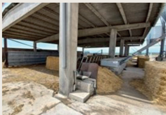
Aménagement en cours de bâtiment pour sevrage post-phase lactée, avec à droite silos à granulés, tuyaux d'amenée vers nourrisseur. Paille en balot puis en vrac dans le râtelier déjà en place. Aire béton sans seuil pour paillage et curage rapide.
