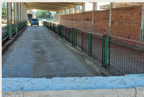
Bâtiment pour sevrage de veaux (phase post-lactée) sur dalle béton sans seuil. Aire paillée avec barrière au milieu pour faciliter le curage tous les 7-10 jours en enfermant les veaux d'un côté puis de l'autre.
