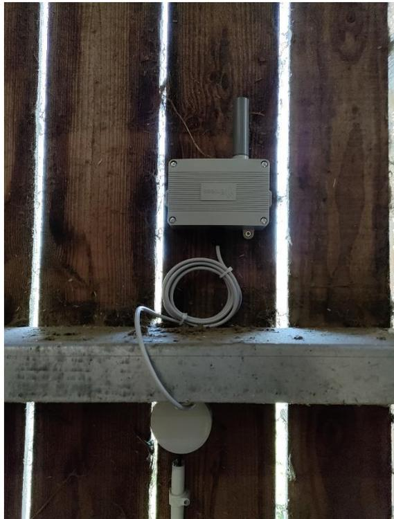
Figure 2 : Compteur d'eau à impulsion
