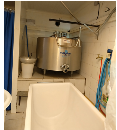
LE COMPRESSEUR DU TANK APORTE DE LA CHALEUR QUAND IL EST SITUÉ DANS LA LAITERIE
