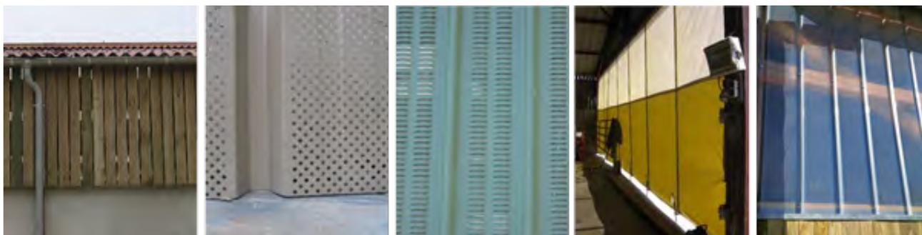
Cinq types de bardages ventilants utilisés fréquemment pour des bâtiments d'élevage : bois posé à claire voie, tôle perforée, tôle à ventelles, matériau souple constitué d'une bâche pleine en partie basse et d'un filet brise-vent en partie supérieure, plaques translucides perforées
