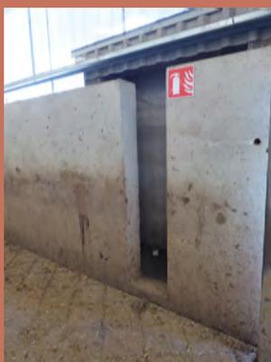
Dans certains cas, les techniciens du centre d'allotement peuvent être amenés à suivre des bovins dans un couloir. Si celui-ci est contre un mur, des refuges inclus dans le béton peuvent être intégrés dès la construction.
