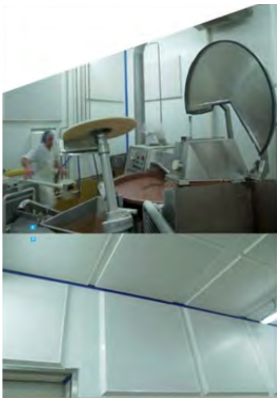
Exemple de traitement acoustique dans une salle cutter
