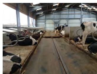
Couloir de circulation en asphalte en stabulation vache laitière
