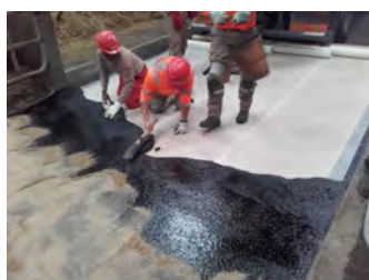
Chantier de réalisation d'un couloir en asphalte par une entreprise spécialisée
