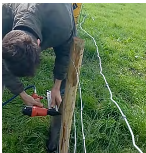
La pose de grillage à l'aide d'une dérouleuse et d'une crampillonneuse à gaz permet de gagner beaucoup de temps.
