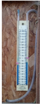
Figure 14 : Dispositif dit de "tube en U" : un tuyau en plastique et une règle graduée forment un manomètre en U et permettent de vérifier que le séchage s'effectue correctement
