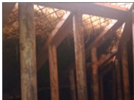
Figure 7 : Vue de dessous des caillebotis métalliques (10x10 cm)
