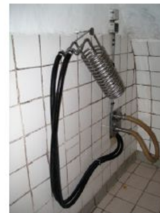
Figure 5 : Serpentin alimenté par l'eau du tank
