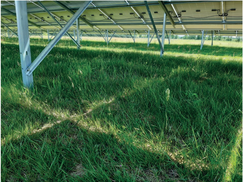
Photo 59 : Centrale agrivoltaïque de Bioule (© Idele, centrale gérée par Neoen)
