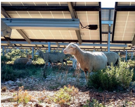
Photo 8 : Centrale photovoltaïque du Castellet (© Voltalia)
