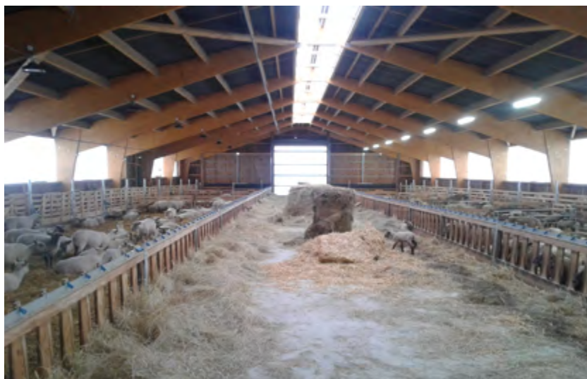
La bergerie demande un aménagement de son mode d'éclairage.
