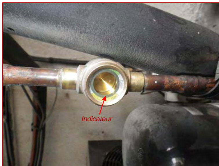
Photo 4 : voyant hygroscopique ; sur cette photo l'indicateur est le cercle gris, qui deviendrait jaune en présence d'humidité. Noter aussi l'absence de bulles dans ce voyant.
