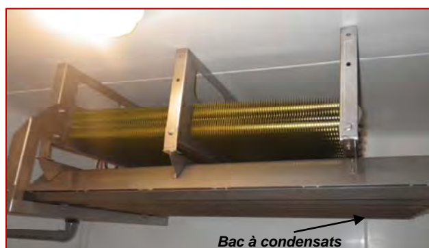
Photo 2 : évaporateur statique Source : A. Michel, Actalia Produits Laitiers Centre de Carmejane
