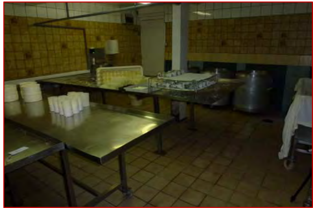
Photos 18 et 19 : murs en carrelage en salles de fabrication Source : G. Allut, CFB et M. Pétrier, CTFC
