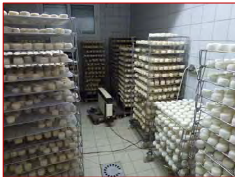
Photo 20 : murs et sols en carrelage dans un hâloir Source : M. Pétrier, CTFC
