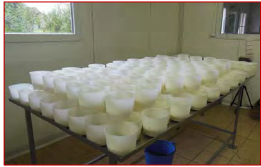
Photo 29 : fenêtres en salle de fabrication Source : A. Chabanon, FRESYCA
