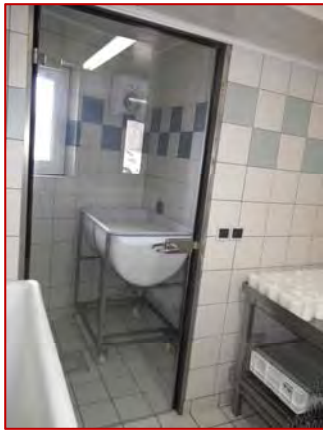
Photos 18 et 19 : murs en carrelage en salles de fabrication Source : G. Allut, CFB et M. Pétrier, CTFC
