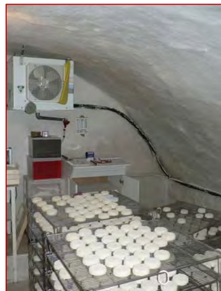
Photo 9 : hâloir dans une cave voûtée – Source : J. Barral, Languedoc Roussillon Elevage
