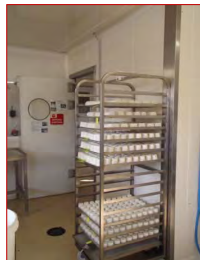
Photo 15 : sol en résine, siphon et porte battante à hublot dans une salle de fabrication Source : G. Allut, CFB
