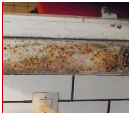
Photos 1, 2, 3 et 4 : condensation sur un plafond ou des encadrements de portes ou baies vitrées en fromagerie : formation de gouttelettes et rouille
