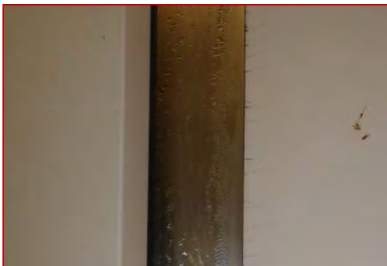
Photos 1, 2, 3 et 4 : condensation sur un plafond ou des encadrements de portes ou baies vitrées en fromagerie : formation de gouttelettes et rouille
