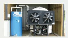
La mise en place du pré refroidisseur assure un gain moyen de 45 %. Mais cela suppose à la fois le bon dimensionnement de l'échangeur en fonction de la cinétique de traite et un besoin en eau de boisson en adéquation avec le volume d'eau réchauffée.
