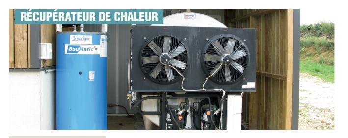
10 WH PAR LITRE DE LAIT, C'est le potentiel moyen d'énergie récupérable au niveau du condenseur du tank à lait
