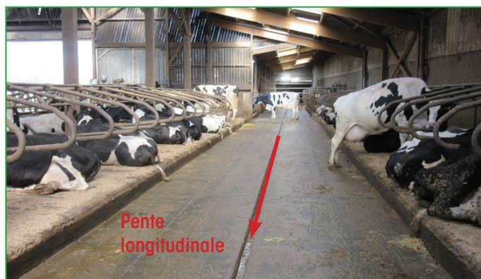
Photo 9 : Pente longitudinale d'un couloir de circulation
