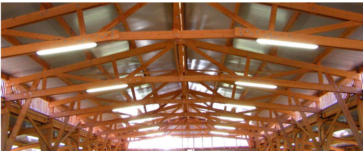
Photographie 3 : un exemple de répartition de luminaires dans un bâtiment d'élevage
