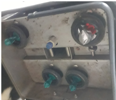
PHOTO 4 : Installation du cône de récupération de l'eau de nettoyage
