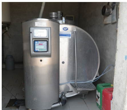
Photo 2 : Le tank à lait, un point critique de l'intervention
