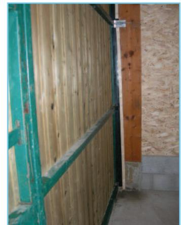
Enfin, pour une protection maximale évitant tout risque de retombée d'air, on recouvre le rail supérieur du portail à l'aide d'un capot retombant et très ajusté, pour qu'aucune entrée d'air parasite ne puisse se produire en partie haute.
