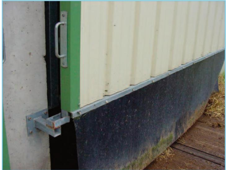
Pour rendre étanche l'intervalle entre le mur et le portail, plutôt qu'une bavette caoutchouc qui peut se déformer dans le temps et perdre de son efficacité, on préfère placer une sorte de brosse assurant de façon durable une protection contre les risques de courants d'air.
