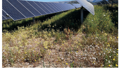
Photo 15 : Parc photovoltaïque à panneaux trackers 1 axe au Castellet (83) (© Voltaïa)
