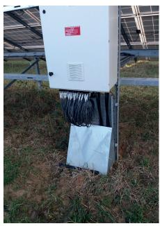
Photo 29 : Câblages électriques laissés apparents à faible hauteur pouvant être rongés par les animaux (© idele)
