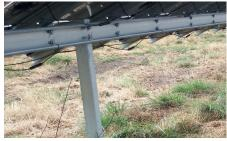
Photo 31 : Exemple de fixation de câbles électriques avec des serrescâbles à l'arrière d'un panneau photovoltaïque (©Idele)
