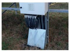
Photo 50: Présence de câbles à 50 cm de haut, risque d'endommagement de la structure sans protection (© Idele)
