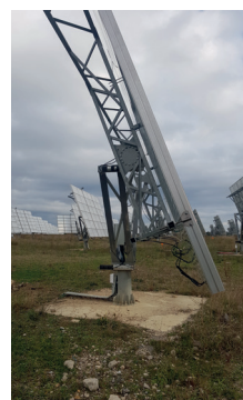
Photo 27 : Double-tracker mono-pieu sur dalle de béton (© Idele)
