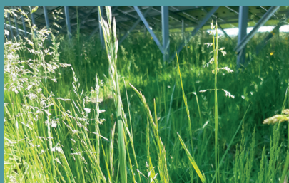
Couvert végétal sur la centrale de Bioule (© Idele, centrale gérée par Neoen)
