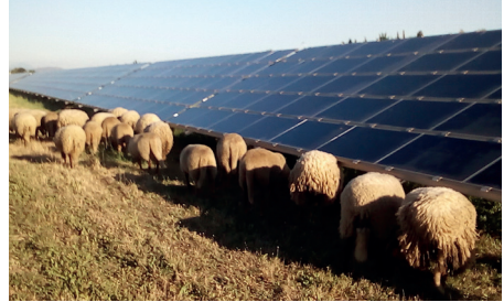
Photo 18 : Des hauteurs de tables parfois très basses (<1 m) (© Idele)
