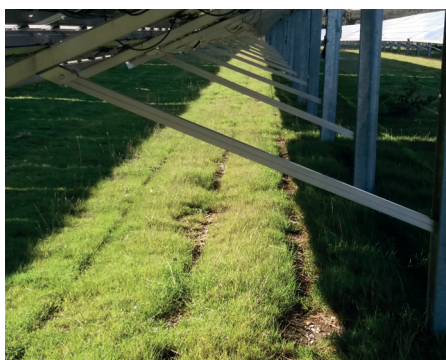
Photo 28 : Table fixe sur mono-pieu battu (© Idele)
