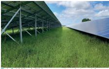
Photo 8 : L'hétérogénéité du rayonnement au sol est accentuée lorsque les panneaux sont bas (© Idele)
