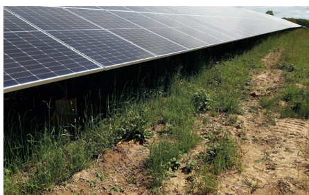
Photos 40 à 44 : Différentes phases de chantiers de construction d'une centrale photovoltaïque (© Neoen, © Idele, © science-in-hd/Unsplash)
