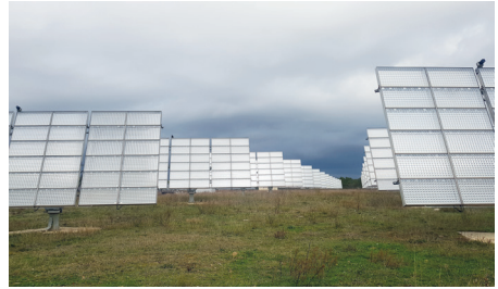
Photo 16 : Panneaux photovoltaïques trackers 2 axes à Grabels (34) (© Idele, parc géré par Neoen)
