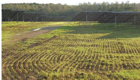
Photo 24 : Prairie semée dans un parc photovoltaïque (© Photosol)
