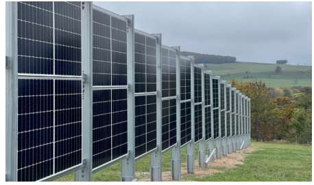
Photo 14 : Haies solaires ou panneaux verticaux (© Engie Green)
