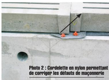
Photo 2 : Cordelette en nylon permettant de corriger les défauts de maçonnerie
