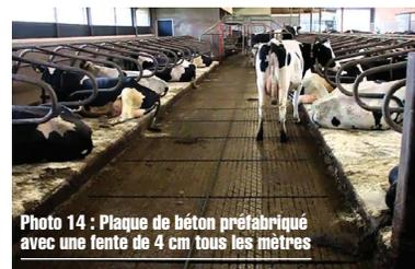
Photo 14 : Plaque de béton préfabriquée avec une lente de 4 cm tous les mètres
