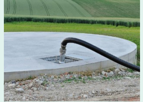
Fosse béton couverte
