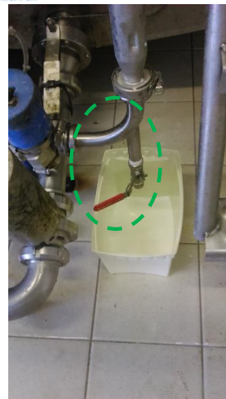
Photo 7.1 : Localisation P4, sur le lactoduc d'évacuation, en amont du tank à lait, pour robots DeLaval
