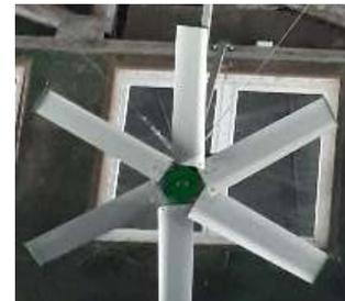
Attention, les brasseurs ne réduisent pas la température ni l'humidité, ils apportent du confort par des vitesses d'air importantes
