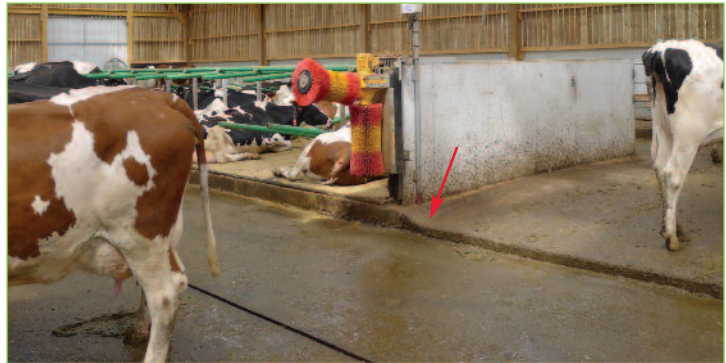
Photo 32 : Passage avec seuil abaissé et pente de 6% environ pour évacuer l'humidité.
