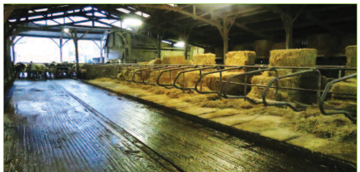
Photo 3 : La formation de flaques sur le couloir de circulation témoigne de la présence de contre-pentes.
