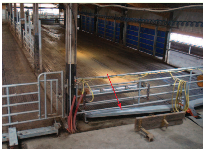
Photo 37 : Barrière poussante raclante.
