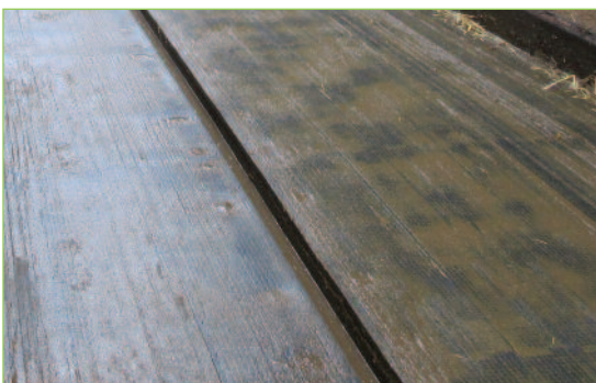
Photo 30 : Fixation des tapis correctement réalisée.
