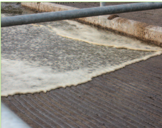
Photo 6 : Hydrocurage d'un couloir de circulation.
