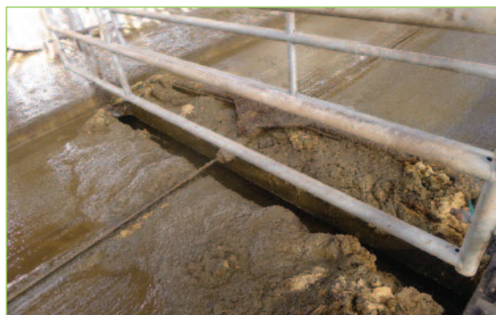
Photo 14 : Canal à lisier au milieu d'un couloir de circulation.
