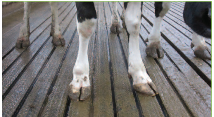
Photo 31 : Le profil de la surface du tapis qui oriente les jus vers les rainures, associé aux pentes longitudinales du couloir et à un raclage toutes les deux heures, permet de garder les pieds des vaches au sec.
