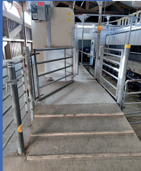
Tasseaux ajoutés pour éviter aux chèvres de glisser lors de leur entrée sur le quai
