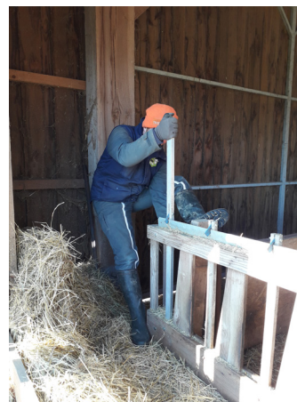
Penser à entretenir les cornadis pour éviter que leur fermeture ne devienne difficile.
