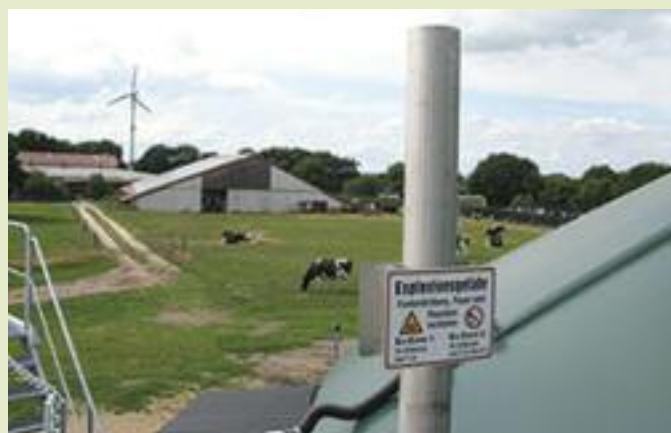
Eolienne, photovoltaïque et méthaniseur dans une exploitation laitière du Schleswig Holstein
