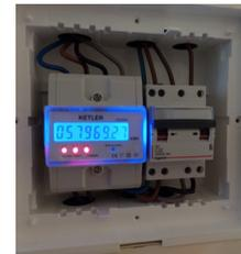
La pose d'un **compteur** permet de suivre la consommation d'une partie de l'installation ou d'un matériel. Sans enregistreur associé, il faut toutefois effectuer un **relevé manuel à pas de temps régulier**.
