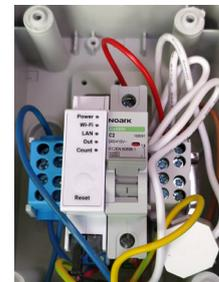
Des **appareils de mesures connectés** peuvent être installés directement dans les tableaux ou dans des coffrets placés à côté. Nécessitant cependant un accès au wifi, ils ont l'avantage de permettre un **suivi à distance des consommations**.
