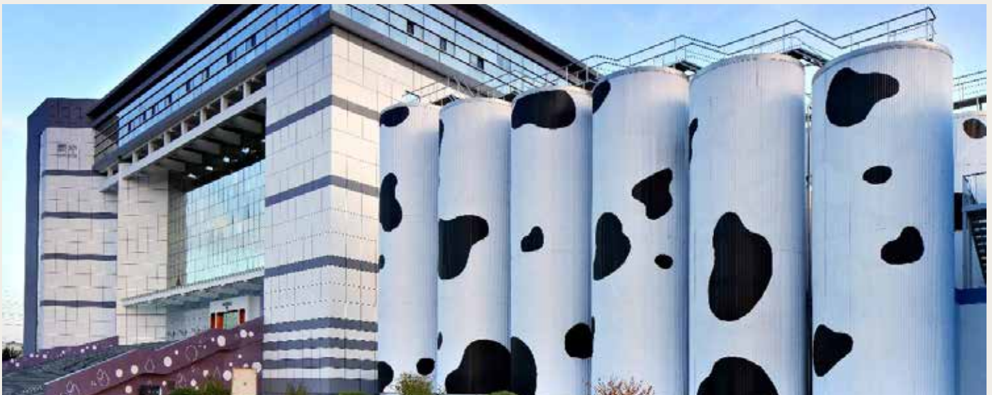
Usine de Mengniu en Mongolie intérieure.
