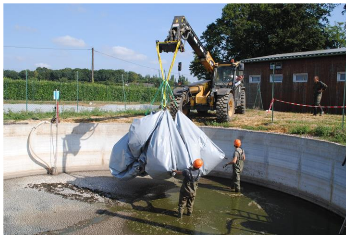
18 juillet 2018 : pose de la bâche Nénufar
