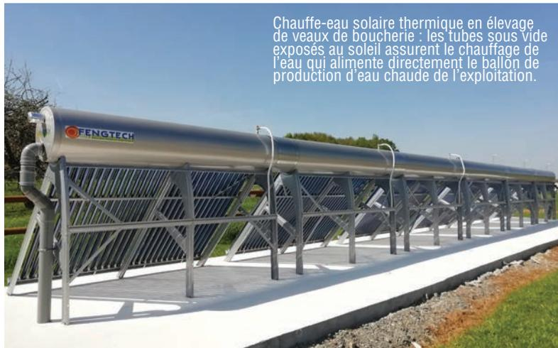
Chauffe-eau solaire thermique en élevage de veaux de boucherie : les tubes sous vide exposés au soleil assurent le chauffage de l'eau qui alimente directement le ballon de production d'eau chaude de l'exploitation.
